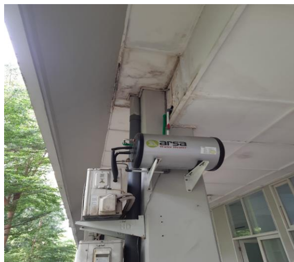
Pemanfaatan Panas Kondensor AC untuk Air Panas Kamar Mandi di ruang Anak Cendrawasih
